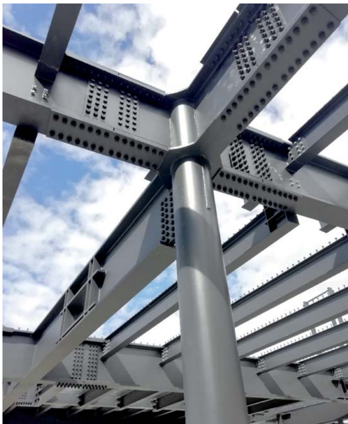
Fig. 4 - Dettaglio nodo travi principali - pilastri
