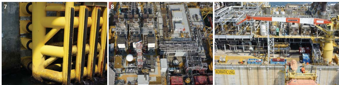
Fig. 7 - Esempio di shock cell. Fig. 8 - Vista panoramica delle strutture Topside. Fig. 9 - Vista dal lato sud delle strutture Topside
