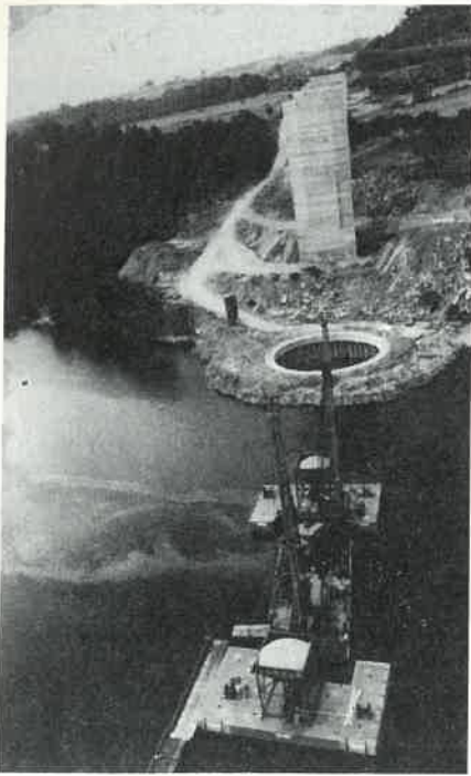
Fig. 5 Veduta del cantiere in centro fiume durante il consolidamento del fondale limoso (gravel-grouting).
