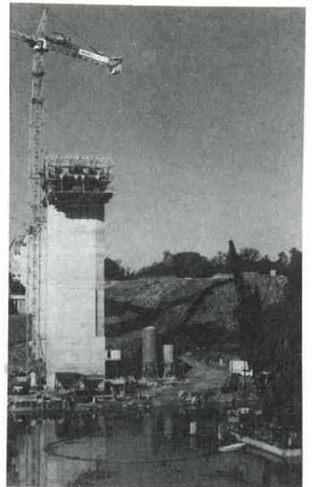
Fig. 7 Infissione delle palancole a formazione della tura circolare; si noti la guida galleggiante per il posizionamento delle palancole.
