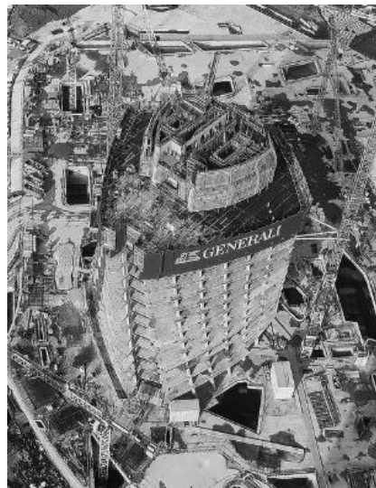
Fig. 4. "Effetto torsione" della torre in costruzione
