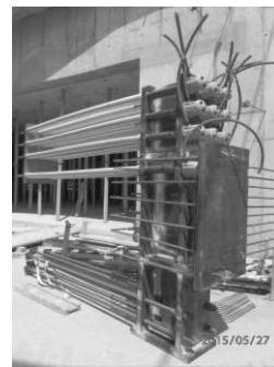
Fig. 6. Coupling beam , estremità da annegare nel setto
