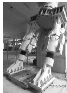
Fig. 11: dissipatori viscosi di base
