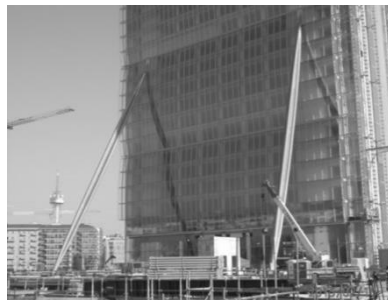
Fig. 10: Puntone P3 e P4 in posizione
