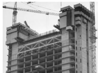
Fig. 7: Trave cintura posizionata in opera
