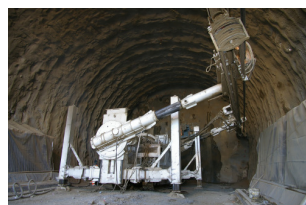
Foto a destra Opere di imbocco della Galleria Collecervo
