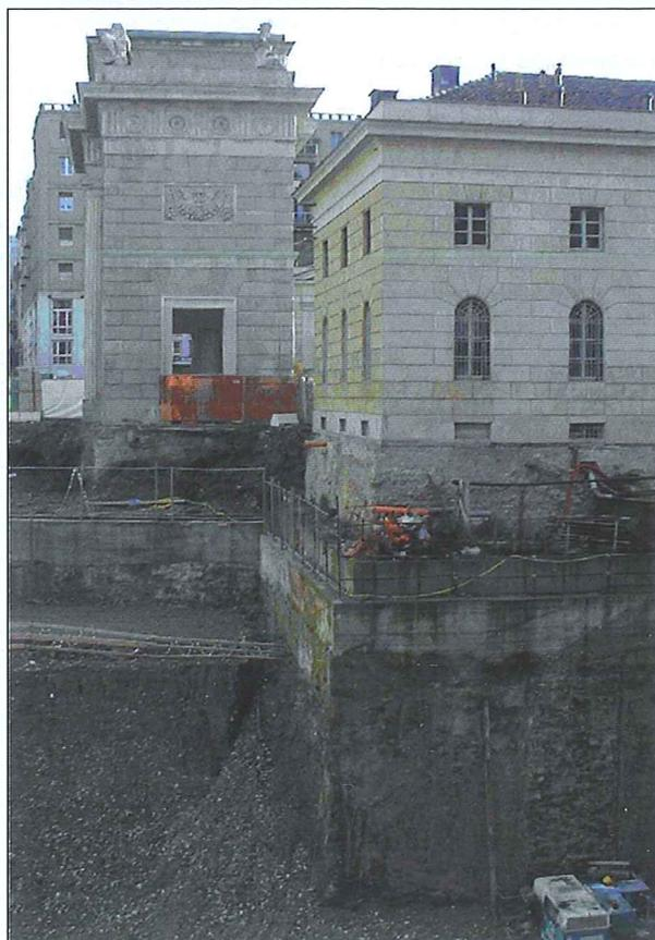
Figura 18 - In un agglomerato urbano densamente costruito, sovente è necessario scavare a ridosso di edifici esistenti
